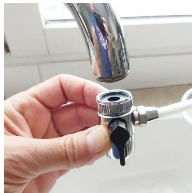
Fig. 13 Visser le raccord-vanne
